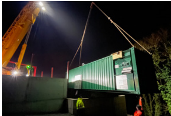
Vor-Ort-Montage: UK, 2025 Sägespäne-Trocknung / 2.800 kg/h
